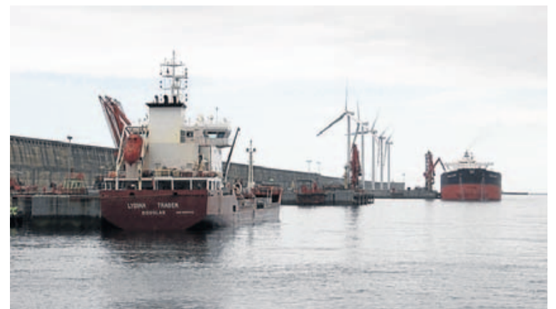
Las firmas energéticas conforman el principal sector del Puerto de Bilbao.
