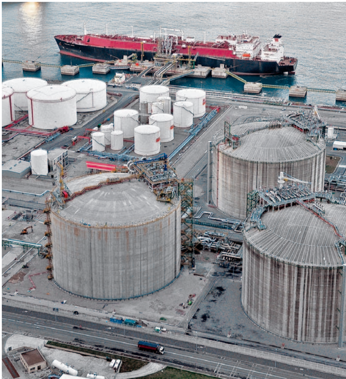
La planta de BBG recibe el 15% del GNL que entra en el sistema gasista.
