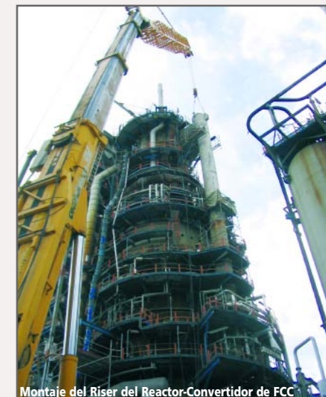
Montaje del Riser del Reactor-Convertidor de FCC
