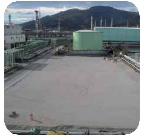
Vista de la planta tras las obras.
