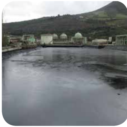
Vista de la planta antes de las obras.
