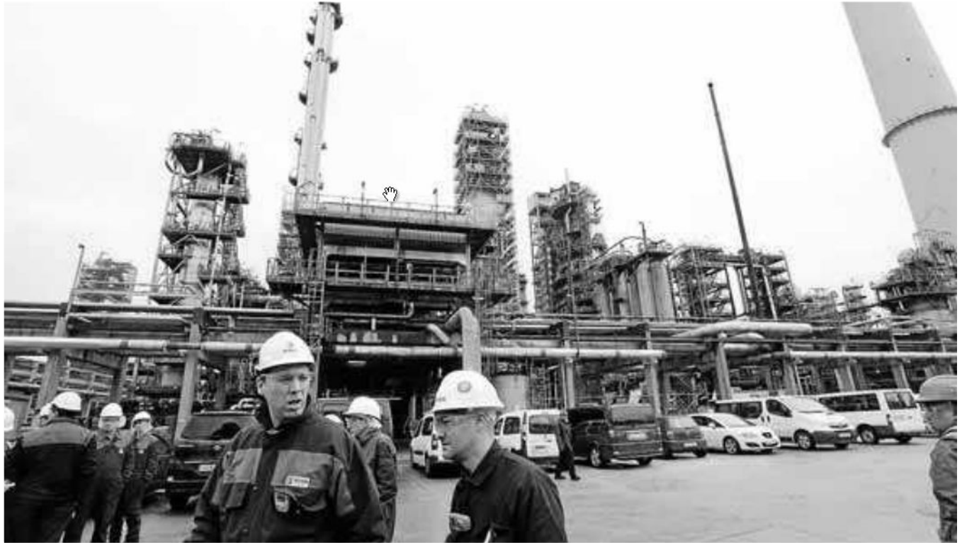
Un grupo de trabajadores, ayer en la planta de Petronor, durante la parada de mantenimiento. Foto: Borja Guerrero
