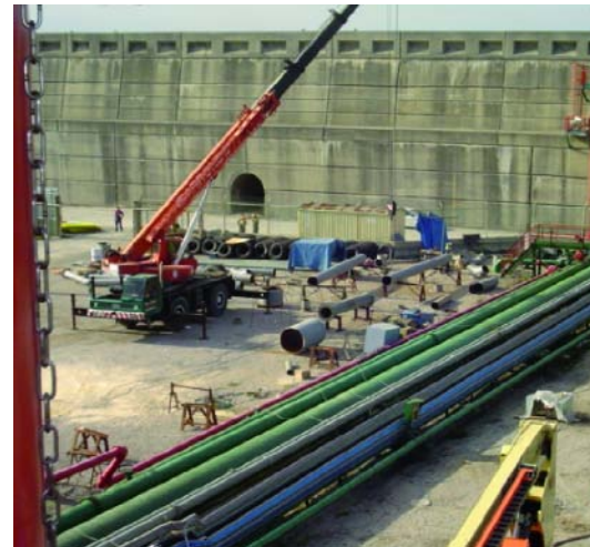
Cambio de las líneas de descarga de crudo.
