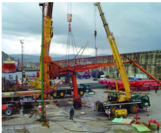
Instalación de los nuevos brazos en SP-1.
