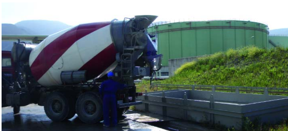
Áreas para el lavado seguro de canaletas de hormigoneras.
