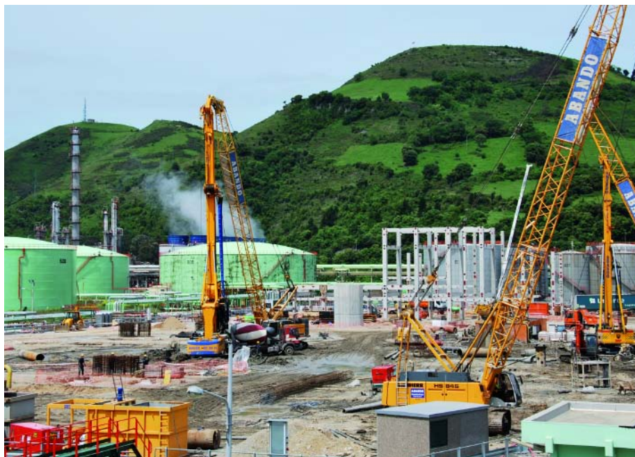
Vista general del desarrollo de las actividades de construcción.
