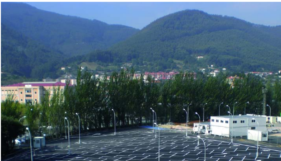
Vista del nuevo aparcamiento y control de accesos para contratistas.
