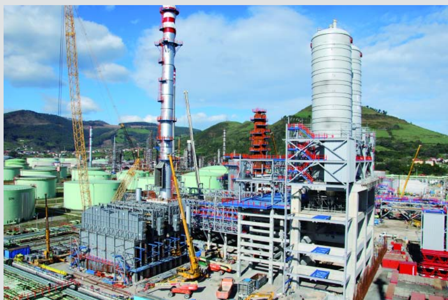
Instalación definitiva de las dos cámaras de coquización de la Unidad de Reducción de Fueloil (URF)
