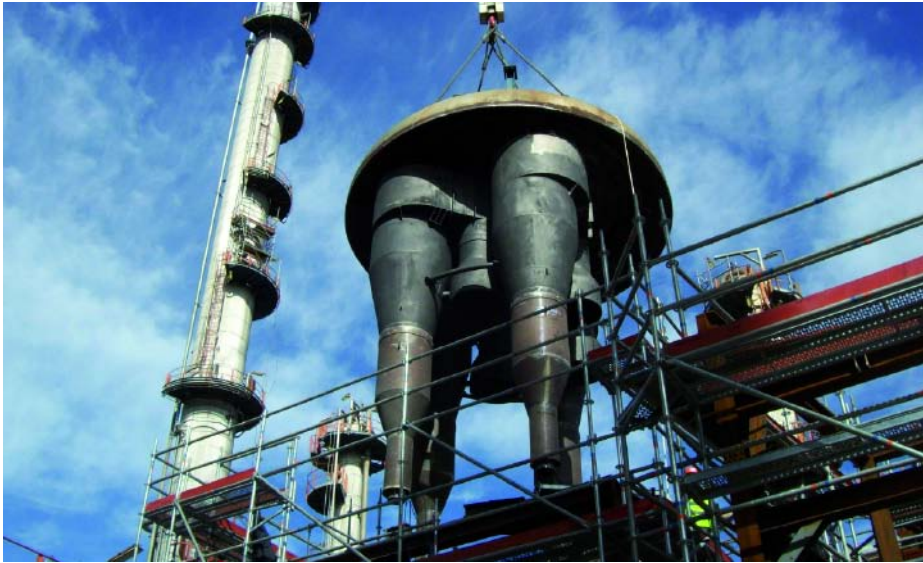
Instalación de la Medusa F3-R-1.
