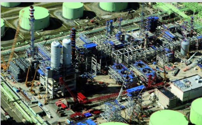
Estado de las obras al año del comienzo de la construcción: marzo de 2010.
