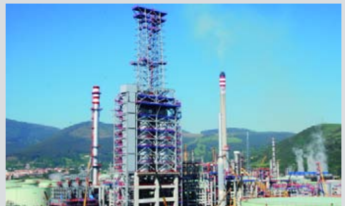
Estado de las obras en mayo de 2010.
