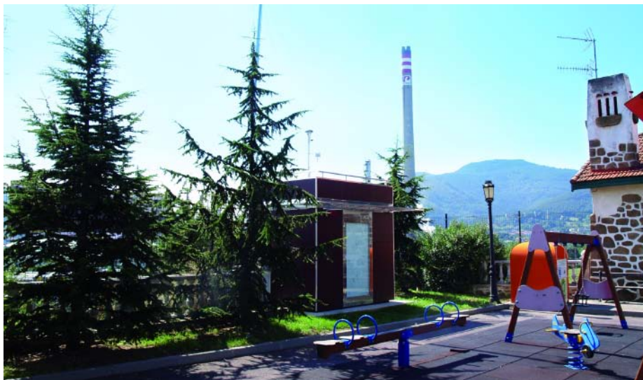
Ubicación de la nueva cabina de control de calidad del aire.
