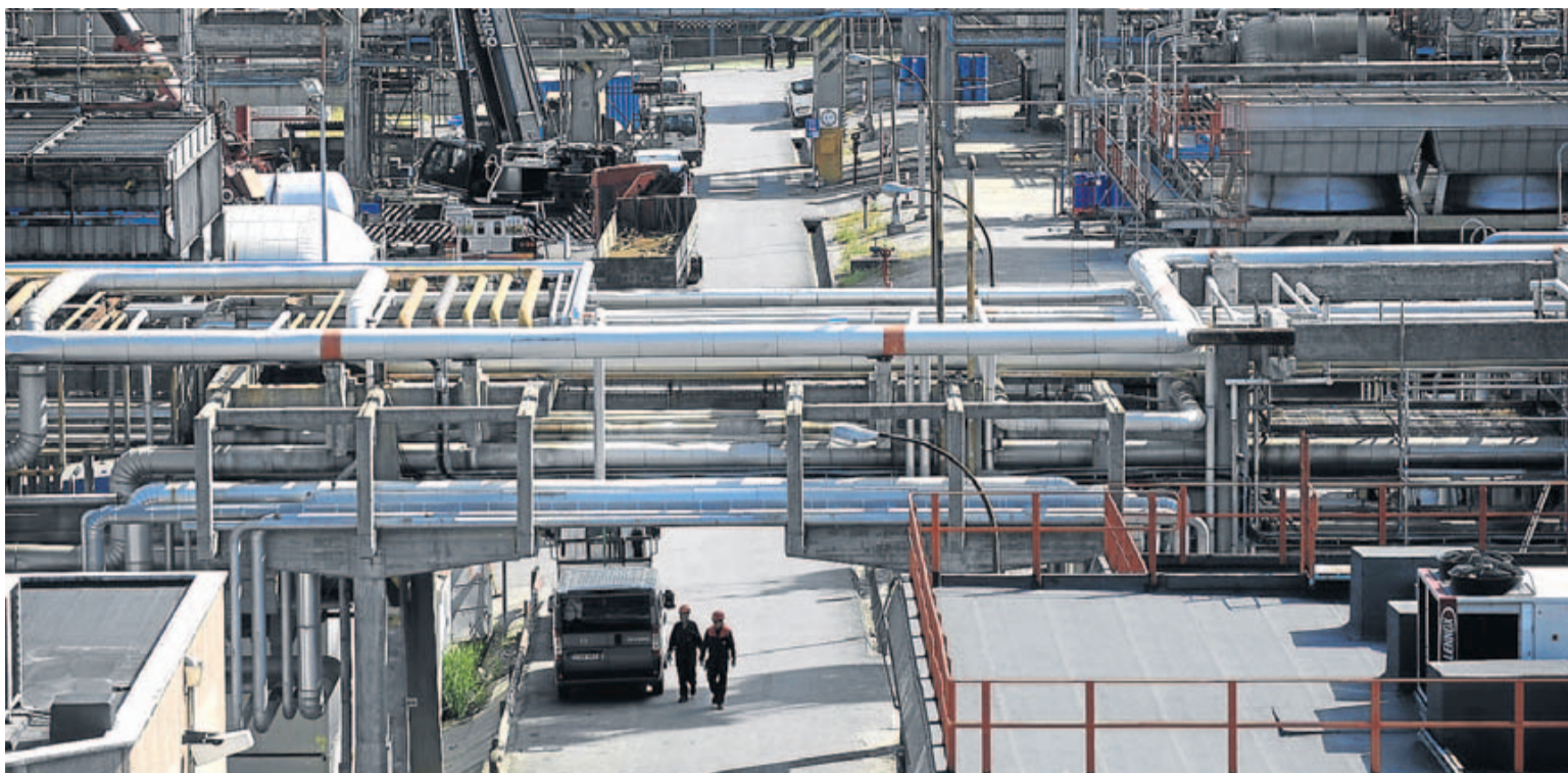
Cientos de operarios de 40 contratas diferentes trabajan desde el 27 de mayo en el área reducida de la Unidad de Refino 1. :: FERNANDO GÓMEZ
