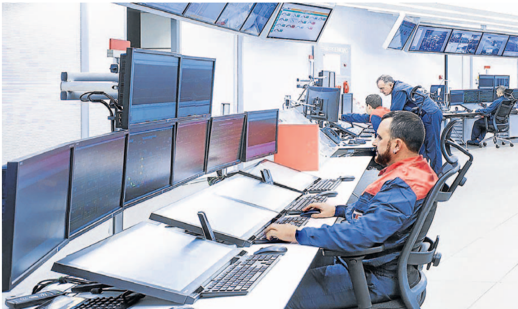
Un equipo de trabajo monitoriza la actividad de la refinería de Petronor, en Muskiz, desde la sala de control. PETRONOR
