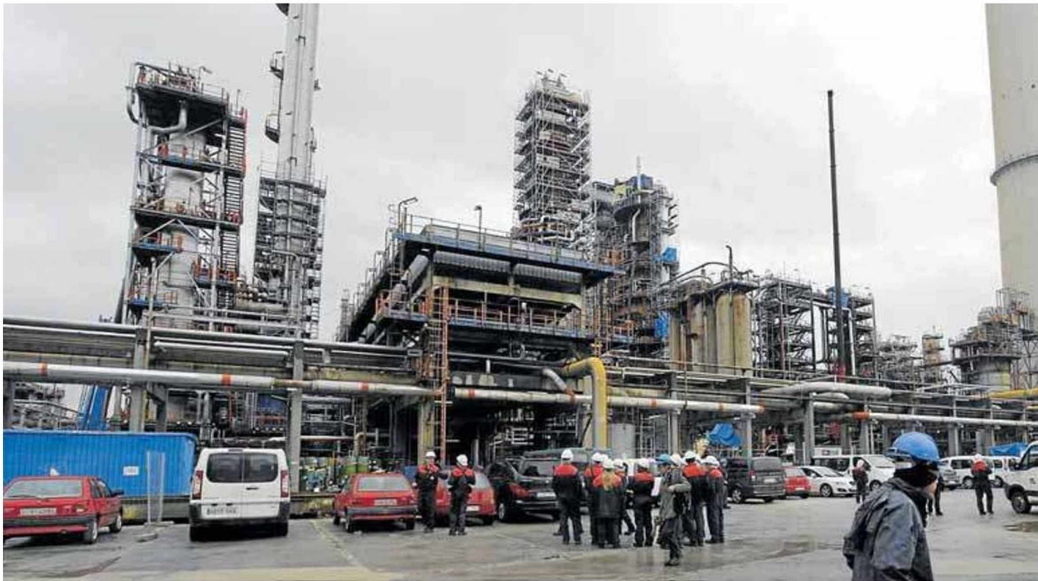
La refinera va a centrar las reformas en la Unidad de Reducción de Fuel oil (URF), más conocida como planta de coque, aunque también se harán trabajos en otras zonas de las instala-
