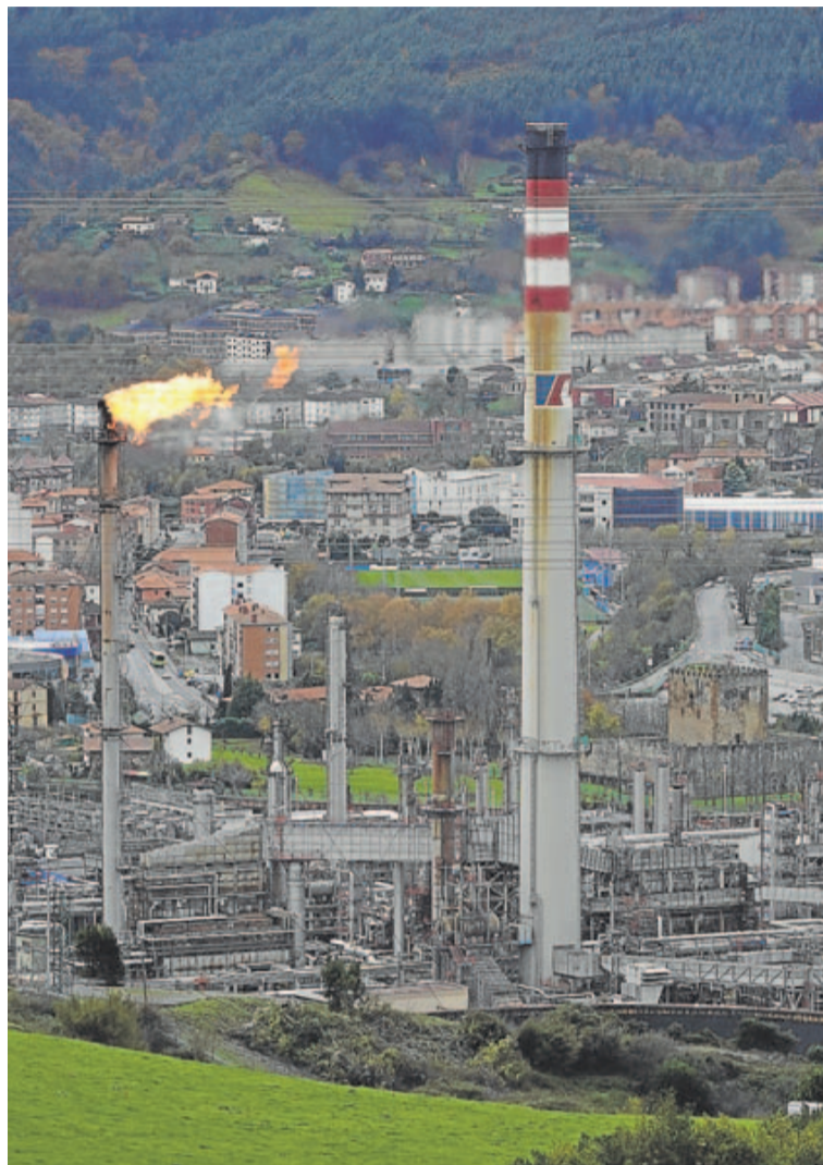
Vista de parte de las instalaciones de la refinería de Muskiz. I. PÉREZ
