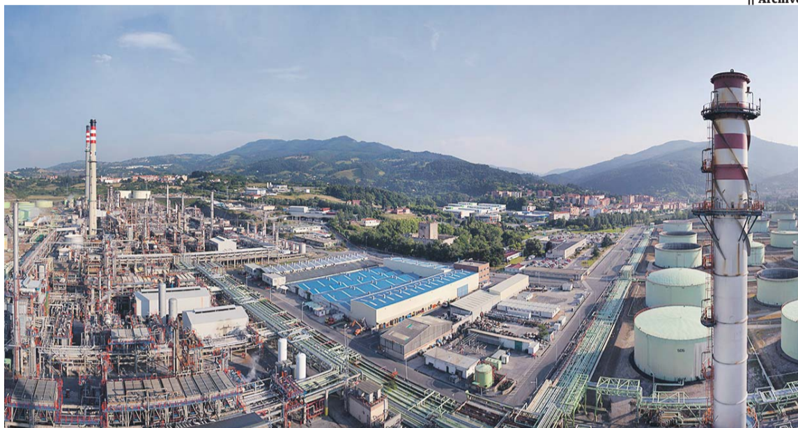
En 2022 Petronor invirtió otros 58 millones en su planta de Coque y en unidades del área de Conversión.
